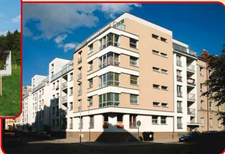
BYTOVÝ DŮM - PLZEŇ
