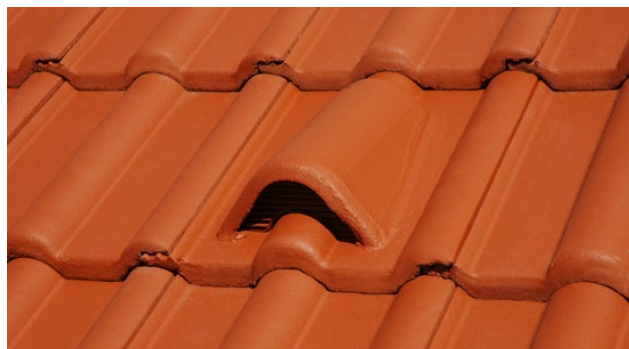
Detailní záběr na tašku větrací ve střeše
