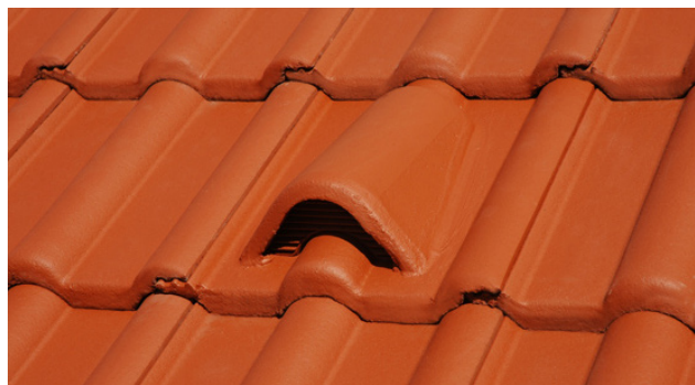
Detailní záběr na tašku větrací ve střeše
