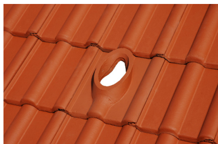
Detailní záběr na tašku prostupovou ve střeše
