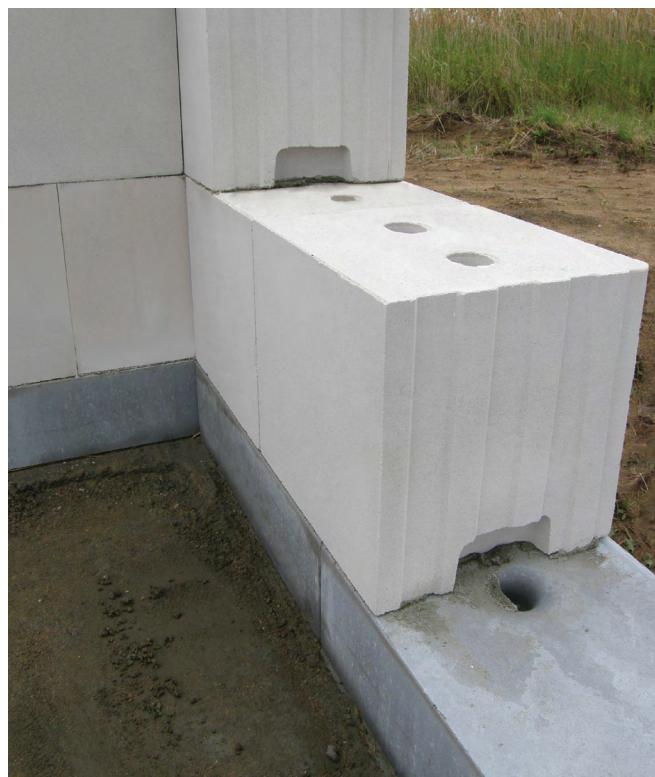
**Přerušení tepelného mostu u obvodové stěny tvarovkou Sendwix 12DF-D THERM**
